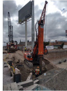
PERFORADORA GEAX DTC 50 Torque: 48 kgm Prof. Max. 22 m Ø Diámetro: 40-120 cm
