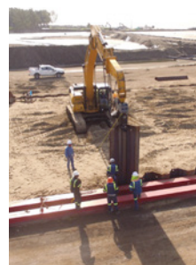
EXCAVADORA CAT 330 CON EXTENSION PARA ACCESORIOS Peso: 30 tons Extensión Tipo Cuello de Ganso: 1.5m
