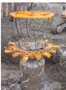
DESCABEZADOR DE PILOTES TAETS 380 Diámetro: 600mm - 1000mm
