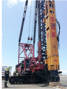
MARTILLO HIDRAULICO PVE 9 TON Capacidad: 7-9 Tons
